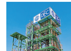
高圧収込試験設備
