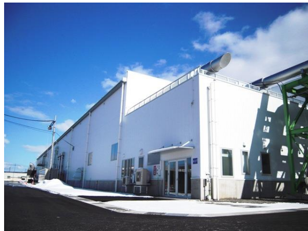
早月工場に増設された多層広幅フィルム製造設備
