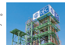
高圧吹込試験設備
