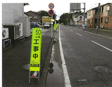
前方工事中看板設置例
